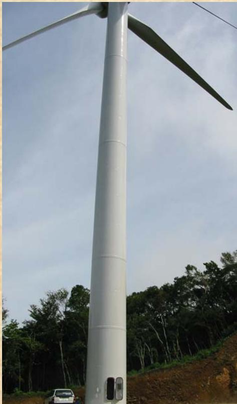
高さ 60 m 出力 1 MW 風車
